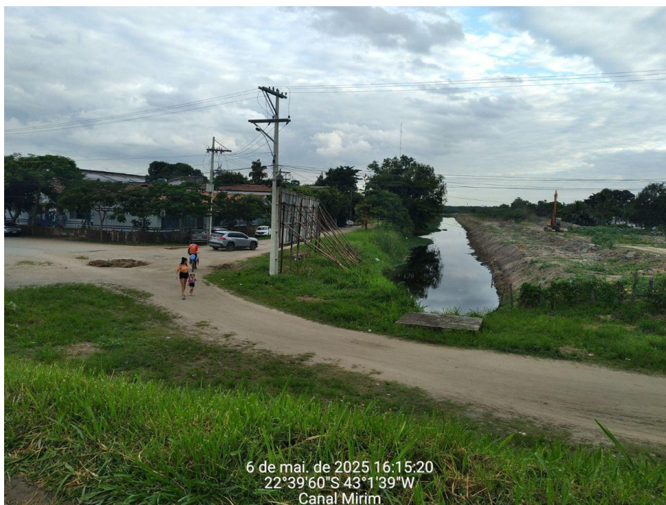
Figura 7: Córrego com esgoto sanitário. Foto cedida pelos educadores do PEA Rendas, Guapimirim, RJ.
